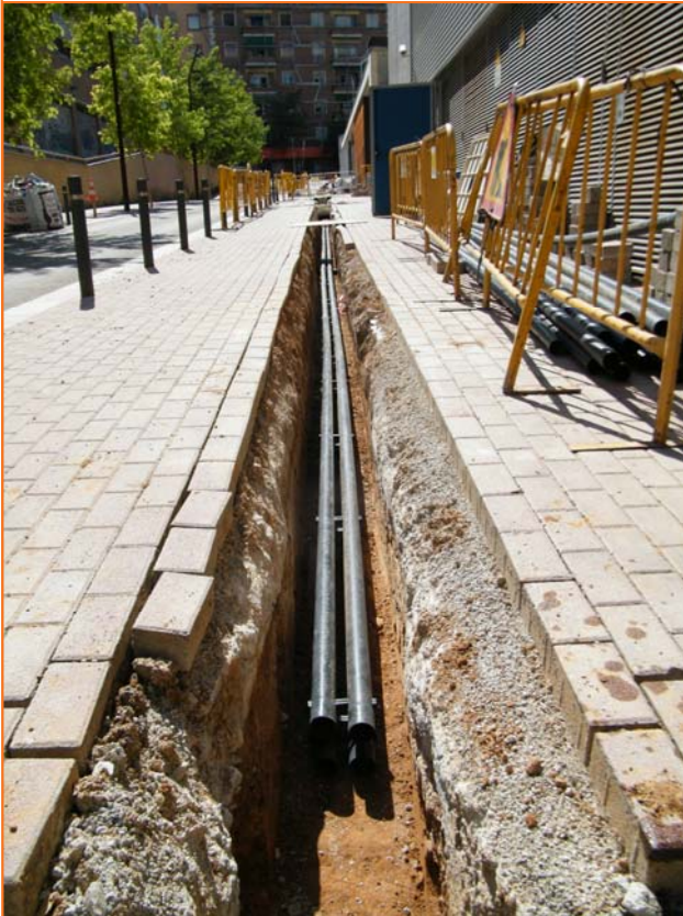
Foto 13. Vista general de la rasa del passatge Maria Àngels Rivas, amb els serveis ja instal·lats.
