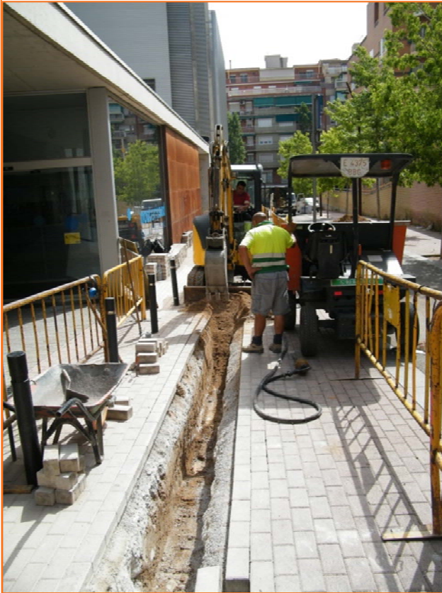
Foto 5. Obertura de la rasa al Passatge Maria Àngels Rivas.
