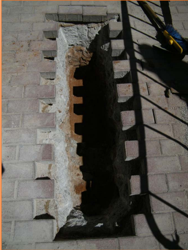
Foto 1. Vista final de la cata 1.
