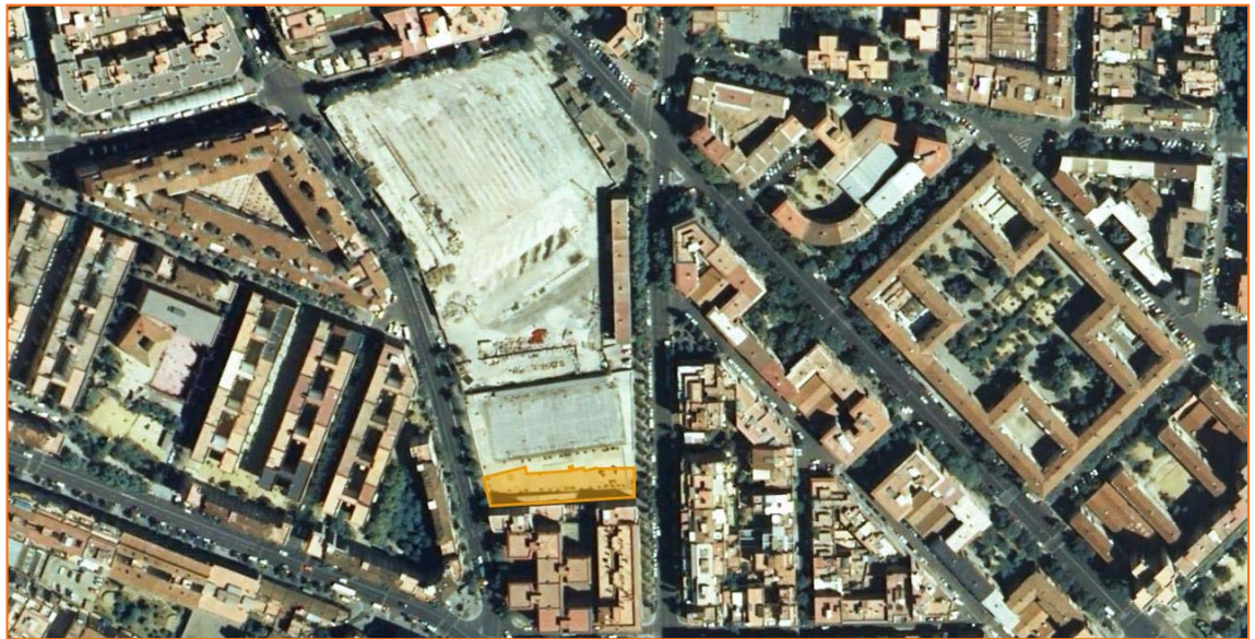
Fig. 5: Cotxeres Borbó, amb les pistes esportives, indicant el traçat actual del passatge de Maria Àngels Rivas, l'any 2006. Extreta de: http://www.icc.cat/vissir3/ , retocada
