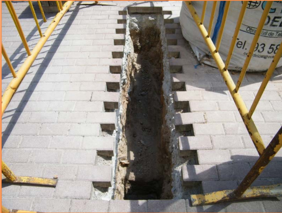
Foto 3. Vista final de la cata 3.
